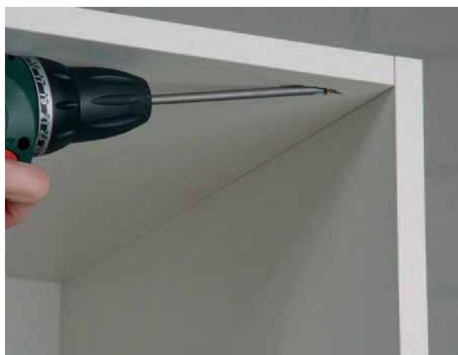
Vissez ! Après perçage, la vis à bois est simplement enfichée à la longueur adéquate dans le perçage, puis vissée avec l'embout spécial. La paroi latérale est ainsi automatiquement resserrée à l'angle pour former un angle d'armoire parfait.
