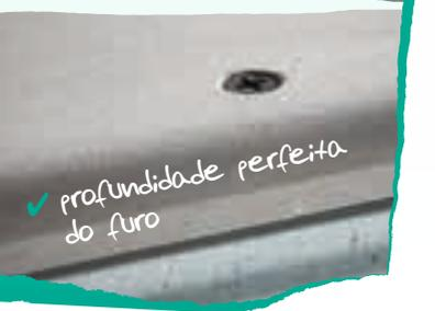
As cabeças dos parafusos deverão ser ligeiramente afundadas, para que mais tarde a espátula possa deslizar. Atenção: Não fure com muita profundidade, caso contrário, danifica a camada de cartão e o parafuso já fica sem apoio suficiente. Quer jogar pelo seguro?
