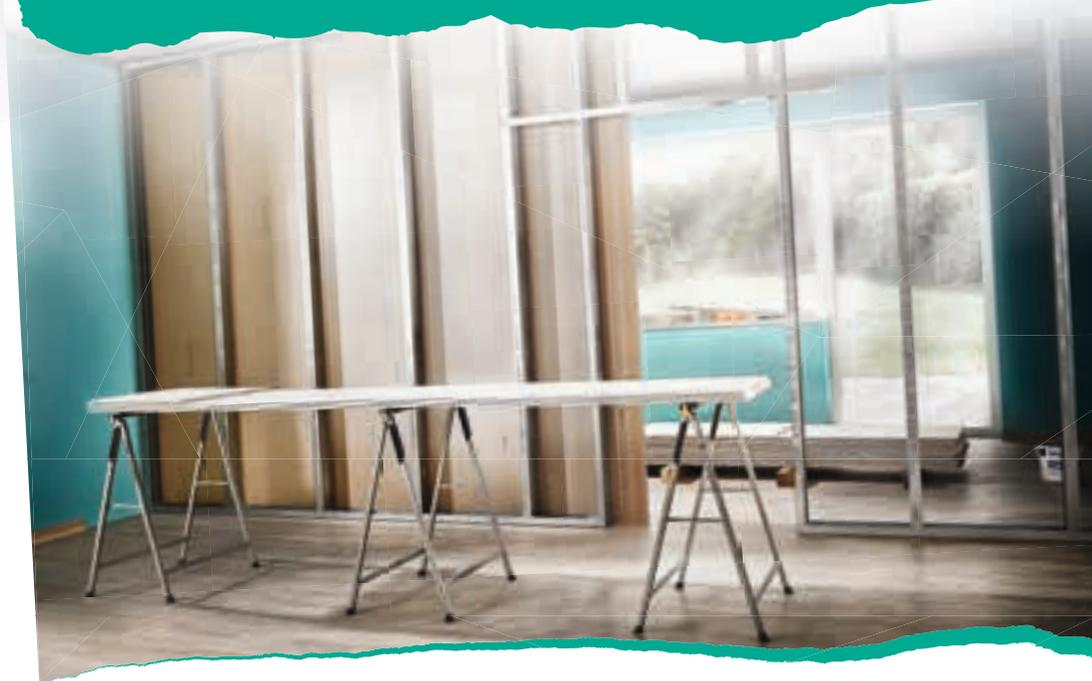
Com os parafusos rápidos para roscas finas, pode fixar as placas de gesso cartonado aos perfis metálicos. »
