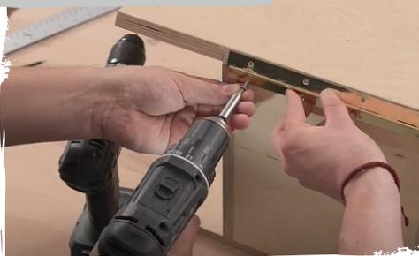
Das **Dach** wird mit einem **Klavierband** an der Rückseite des Korpus verschraubt.
