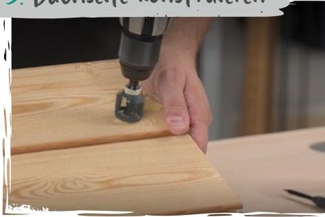
Richtet zwei **Stülp-schalungsbretter** mit gleichmäßigem Überstand zu beiden Seiten auf dem Korpus aus. **Bohrt und senkt** an den Kontaktpunkten mit dem Giebel vor und **fixiert die Bretter** an einer Dachseite mit **Edelstahlschrauben**. Achtet darauf, dass die Oberkante der Bretter ca. 1 cm vom Firstscheitelpunkt entfernt ist.
