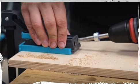
Nun werden die **Giebel** sowie die **Trennwand** mit den **Seitewänden** mithilfe des **Undercover Jigs** unsichtbar verschraubt (Trennwand mit 10 cm Abstand zum vorderen Giebel anbringen.). Wichtig: Die beiden Eingänge müssen **diagonal** gegenüberliegen.
