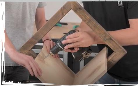
Befestigt das **vormontierte Dach** mit einer sichtbaren Verschraubung direkt von unten am Rahmen und achtet auf einen gleichen Überstand des Daches zu beiden Seiten.
