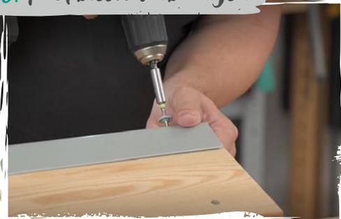
An der Dachseite, die man öffnen kann, bringt ihr nun mit **Spenglerschrauben** ein **Firstblech** an.
