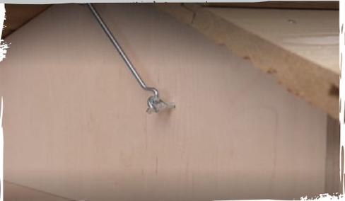
Befestigt zuletzt einen **Hakenverschluss** an der Rückseite. Dreht dazu mit dem **Haken-schraubendreher** eine **Schrauböse** in den Giebel und an der Unterseite des klappbaren Dachüberstands einen Haken ein.
