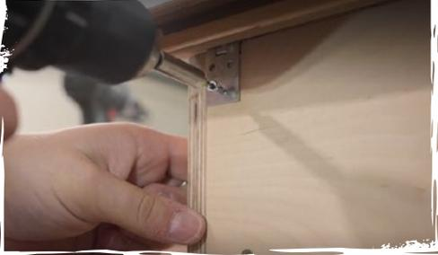
Nachdem der Leim getrocknet ist, legt ihr die miteinander verbundenen Bretter auf die noch freie Dachfläche und richtet sie ebenfalls mit gleichmäßigem Überstand aus. Bringt nun zwei **Scharniere** an der Unterseite der **Traufe** an und verschraubt diese Scharniere mit der **Seitenwand** des Hauses.
