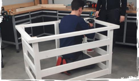
Nun wird der Korpus in den Grundrahmen gesetzt. **Verschraube** diese beide Elemente. Damit die Verschraubungen nicht sichtbar sind, bereitest du sie mit einem **Forstnerbohrer** vor. Das daraus entstehende Loch wird mit einem **Konusplättchen** verblendet.
