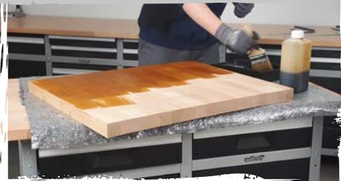
Trattare il pannello di copertura con un mordente in tonalità rovere. Prima tuttavia è necessario lavorare il pannello (bagnatura, levigatura). Lasciamo asciugare il mordente da due a tre ore. Per la sigillatura utilizziamo una vernice trasparente a base acrilica. Dopo avere rispettato il tempo di asciugatura procediamo nuovamente a levigare e verniciare.
