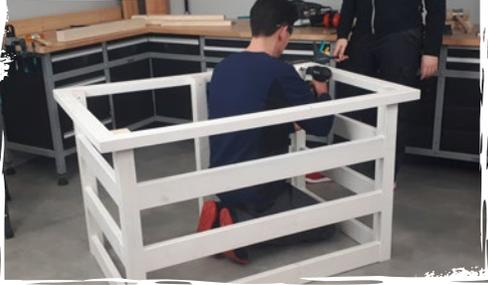
Ahora se coloca el cuerpo en el bastidor base. **Atornillamos** estos dos elementos. Para que las uniones atornilladas no se vean, las preparamos con una **broca Forstner**. El orificio resultante se tapa con una **plaquita cónica**.
